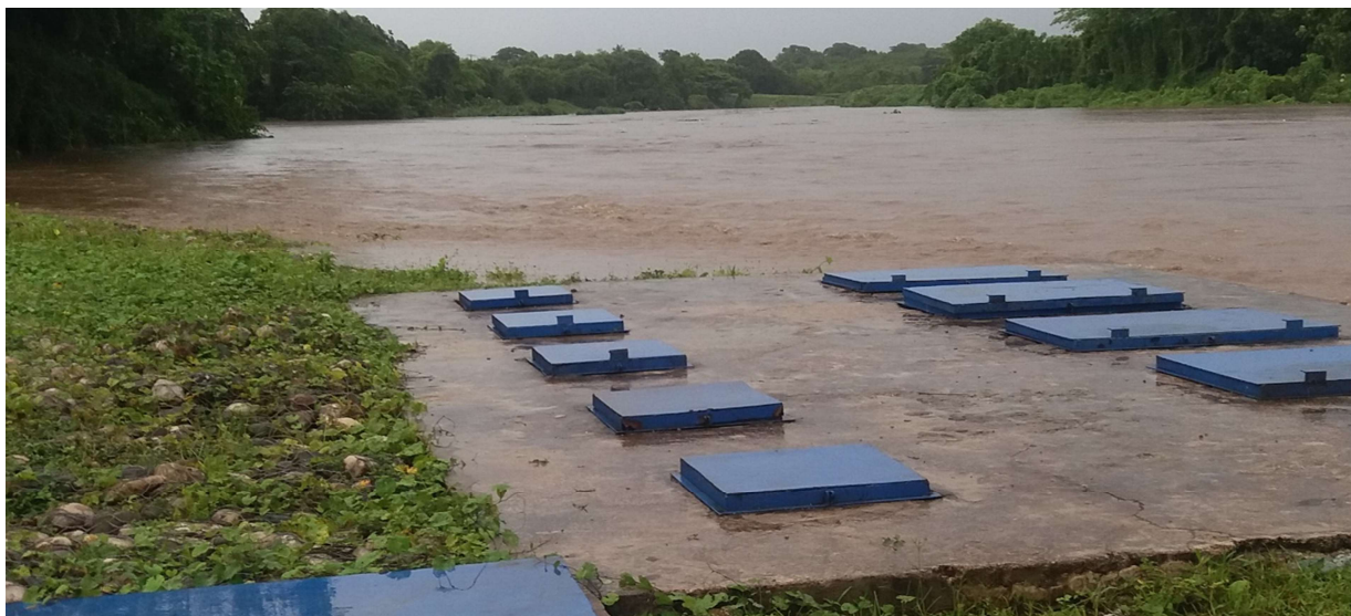
Foto 1. Toma de agua en el Río Soco bajo inundación durante precipitaciones intensas.
